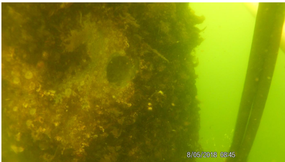
Fot. 8,9. Zdjęcia otworu po wykonanym odwiercie pala podpory nr 12
