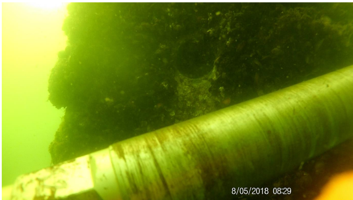
Fot. 7. Zdjęcie otworu po wykonanym odwiercie pala podpory nr 3
